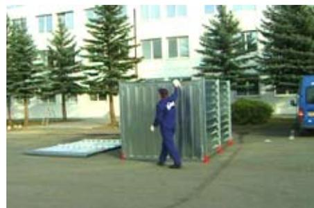
La paroi arrière est placée de l'intérieur entre les deux parois latérales. Le bourrelet de la feuille trapézoïdale est vertical. Le profilé d'angle de la paroi arrière doit être en haut, le profil Z en bas. Il faut veiller à ce que le coude du profilé Z aille vers l'extérieur en bas.
