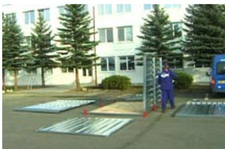
Retirez les pinces entre les sangles centrales des panneaux latéraux et soulevez un panneau latéral sur le côté. Retirez maintenant les feuilles en U de connexion des supports inférieurs, elles ne sont plus nécessaires.
