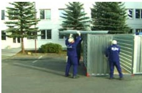
La paroi de la porte est mise en place de la même manière que la paroi arrière. Après la mise en place, les deux portes sont ouvertes de manière à ce que la paroi complète de la porte ne puisse pas tomber vers l'intérieur.
