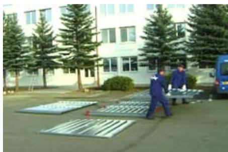
Le conteneur doit montésur une surface plane. Desserrez toutes les vis du toit d'environ 5 mm et enlevez les vis latérales. Maintenant, soulevez le toit, les parois extérieures et posé les de côté.
