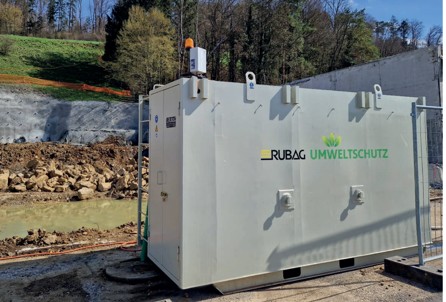
Hangsicherung und Aushub: 10 m 3 Becken aus unserem MietPark im Einsatz in Bubendorf BL auf der Baustelle der Firma Alter Aushub & Abbruch
