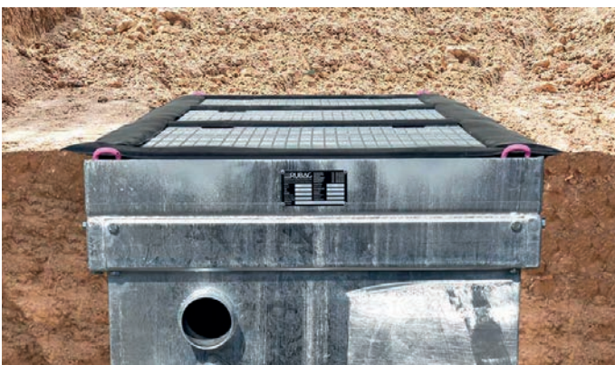
4 m 3 Versenkbecken versenkt im Boden (symbolischer Einbau)
