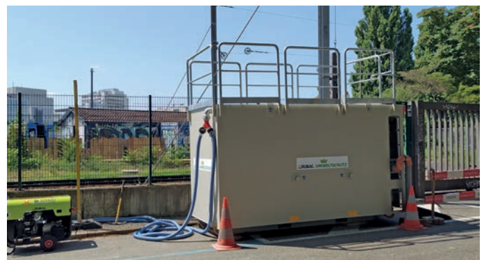
10 m 3 Becken mit integriertem Technik- und Gasschrank
