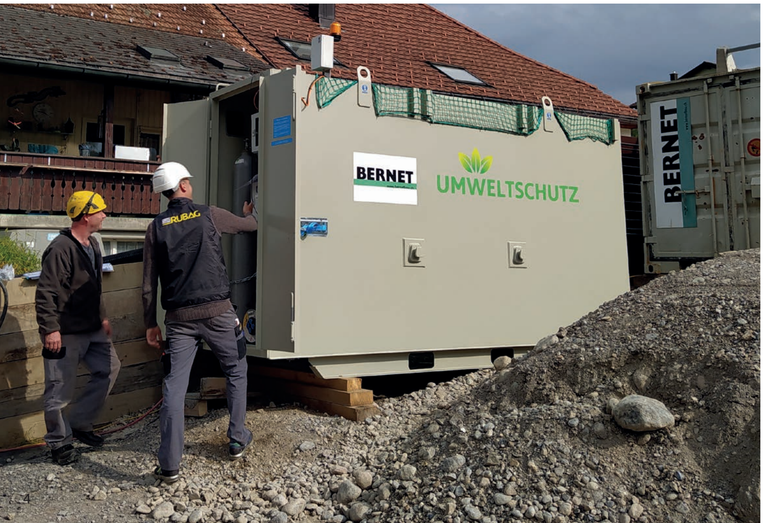
Fachberatung durch unseren Spezialisten auf der Baustelle der Firma Bernet in Gommiswald. Auf dieser Baustelle kommt ein kompaktes 10 m 3 Becken zum Einsatz.
