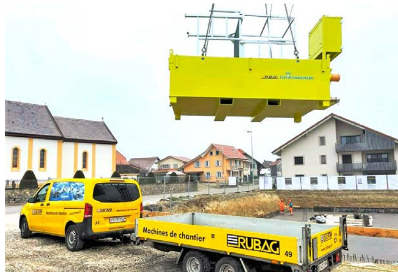
4 m 3 Becken in Kundenfarbe wird an den Einsatzort gehoben
