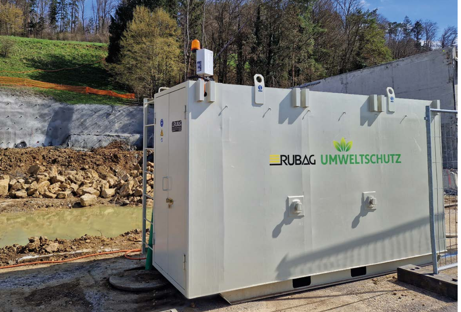
Hangsicherung und Aushub: 10 m 3 Becken aus unserem MietPark im Einsatz in Bubendorf BL auf der Baustelle der Firma Alter Aushub & Abbruch
