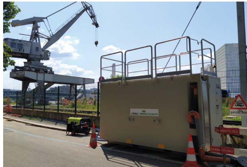
Aus unserem MietPark: 10 m 3 Becken mit Waschaufsatz und Geländer im Einsatz am Basler Rheinhafen
