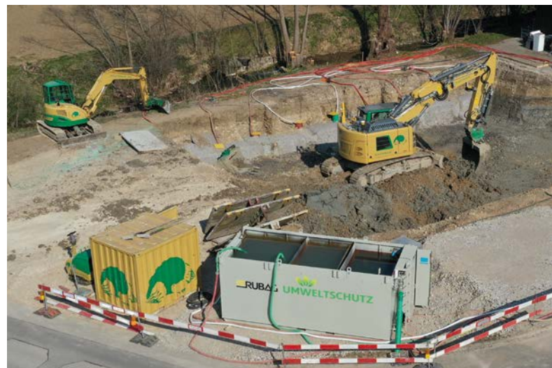
Baustelle der Firma Graf AG, wo das gesammelte Grundwasser in einem gemieteten 20 m 3 Becken neutralisiert wird.
